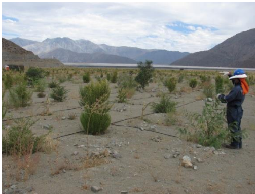
Fotos 5 a 8: Secuencia de establecimiento de la plantación sobre la primera sección del tranque cubierta con material granular (ensayo de etapa I).
