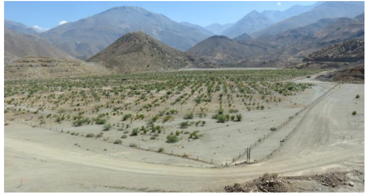
Fotos 5 a 8: Secuencia de establecimiento de la plantación sobre la primera sección del tranque cubierta con material granular (ensayo de etapa I).
