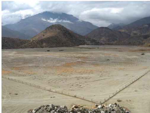
Fotos 5 a 8: Secuencia de establecimiento de la plantación sobre la primera sección del tranque cubierta con material granular (ensayo de etapa I).
